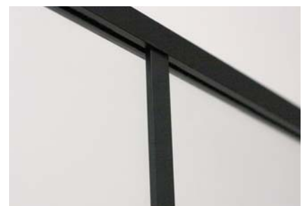
■ Vertikalūs aliuminio profiliai stiklo išorėje
